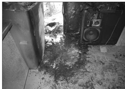
[사진 17] 컨테이너 출입문 바닥부분의 연소형태
