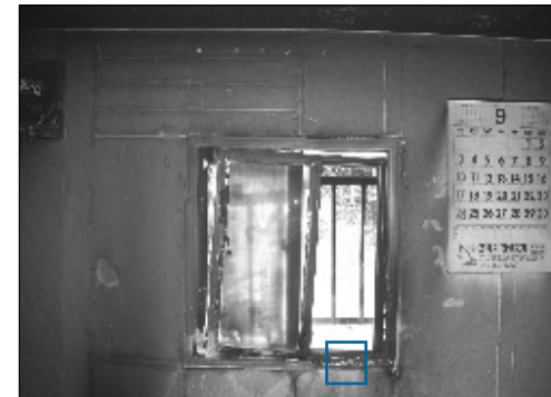
[사진 11] 사진 9 □부분, 유리창 부분의 연소형태
