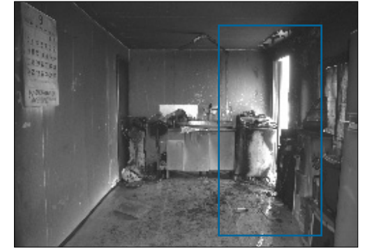
[사진 10] 컨테이너 내부, 우측방향의 연소형태
