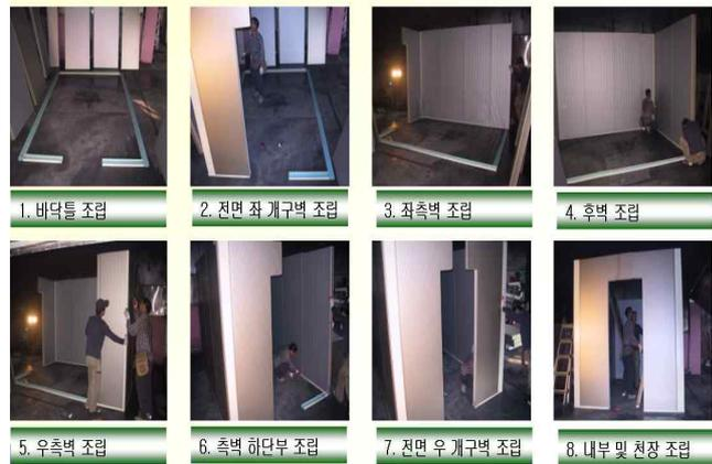
그림3. 시험체 제작 모습(자체조립형)
