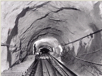
사진 5. 사고 전 터널 안의 모습
