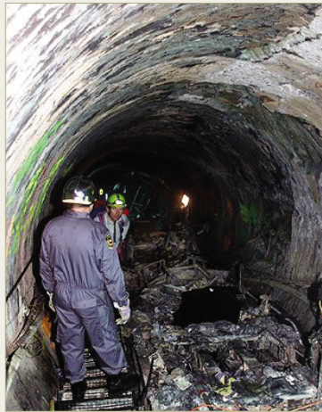
사진 6. 협소한 터널 내
