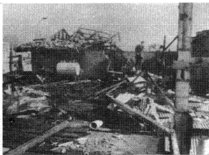
建物の罹災狀態
