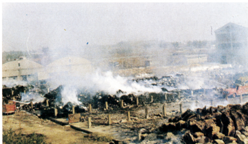
全損된 建物 및 動産
