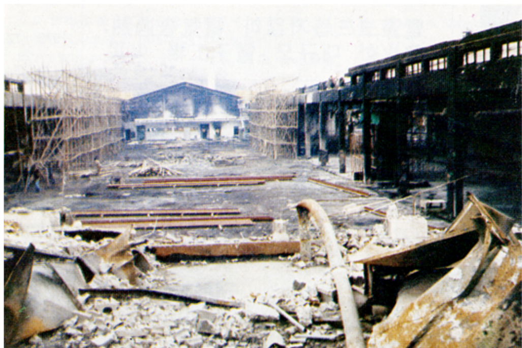
焼残物 撤去後の Angle Truss 지붕 부위
