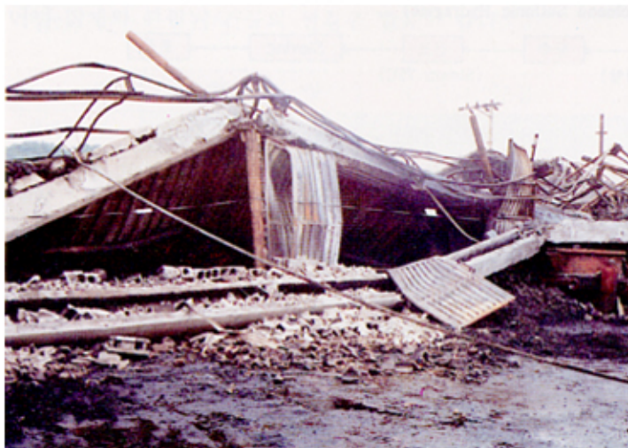
〈발화건물의 붕괴된 모습〉 화공약품 창고 2층 건물이 이변화재로 완전히 붕괴 되었다.
