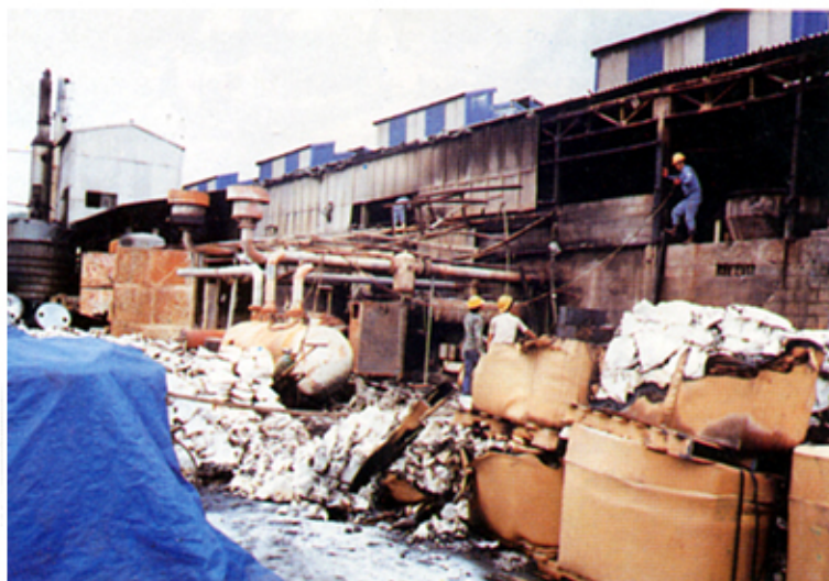
〈본공장 건물의 燒損〉 화공약품이 타면서 내부는 열기로 본공장의 일부가 연소피해를 입었다. 다행히 공장 내부로는 확대되지 않았다.
