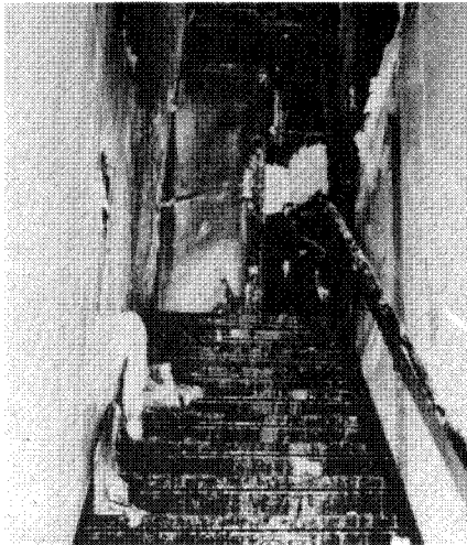
〈9층에서 본 10층 B계단의 상황〉 본 계단은 소방대원들이 최초로 진입을 시도했던 곳으로 화재의 수직확산의 주요인이 되었다.
