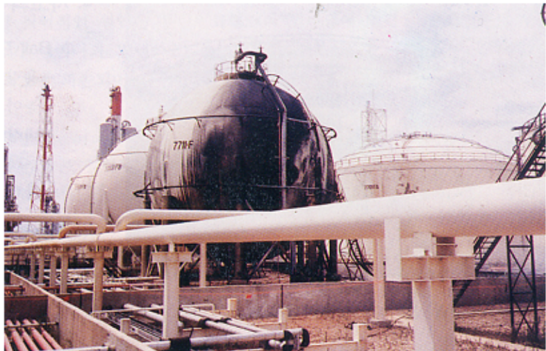
〈사고탱크와 주변의 탱크 배치 상태〉 사고탱크의 상하 및 좌우에 30m 정도의 간격으로 가스탱크 및 나프타탱크가 설치되어 있었다.
