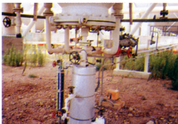
〈사고탱크와 동일유형의 탱크 일부분〉 Drain Pot가 보존되어 있는 상태로 보이고 있다.
