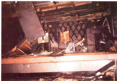
〈무대주위의 소실모습〉 휘발유를 뿌리고 불을 질러 무대부는 완전소실되었다. 무대장식물, 악기류, 조명기구 등이 완전히 타버렸다.
