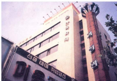
〈화재가 발생한 지하 1층, 지상 7층의 N빌딩〉
