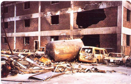
▲ 사진 1. 프로판 탱크 중량이 절단되어 날아가다 인근 건물 벽체에 맞고 떨어진다
