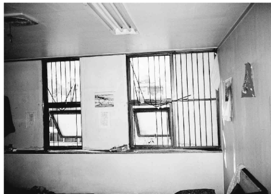
[그림2. 2층 창문에 설치된 쇠창살]
