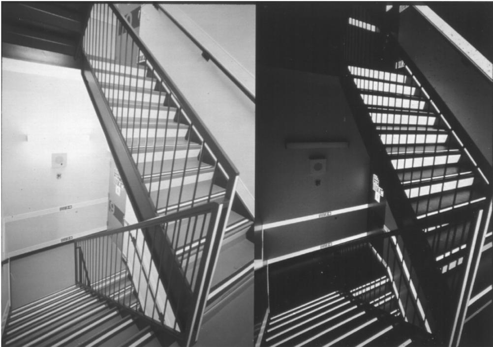
[그림1] 일반조명상태와 암흑상태에서의 피난로유도시스템
