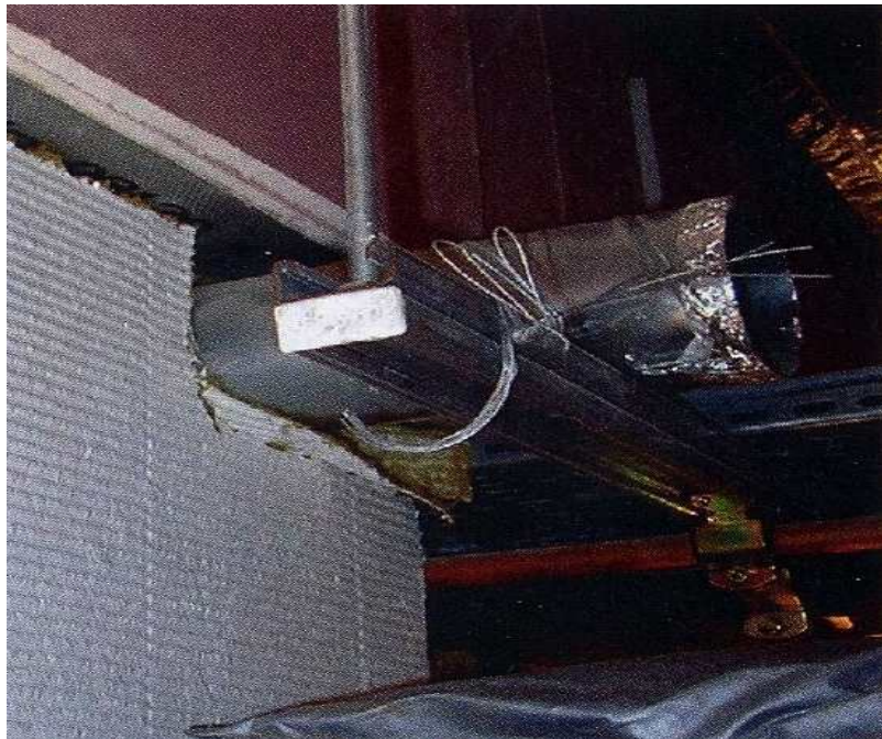
그림 1. 구획을 관통하는 배관 주변의 충전재가 훼손되는 것과 같이 방화구획이 손상되는지를 확인해야 한다.
