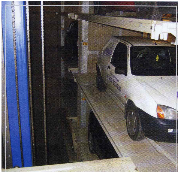
<그림-3> 영국의 현대식 자동차 스택커(stacker)
