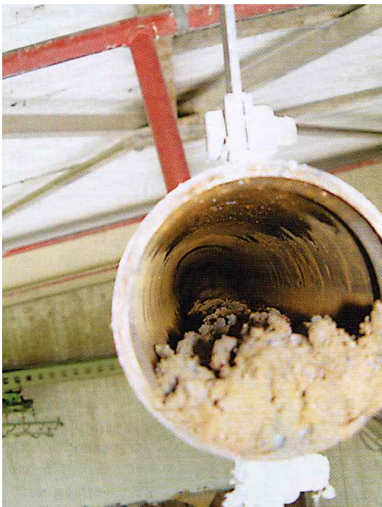
그림 2: 고정된 침전물이 배관 직경의 3분의 1이상이 막혀있다.
