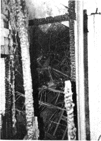
▲ 2層에서 屋上으로 통하는 屋內階段 階段室內에 의자등이 쌓여 있어 避難路로 使用되지 못했다.
