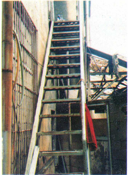
▲ 建物北側의 非常階段
