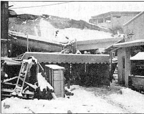
〈1층~3층 부분이 화재로 폭삭 붕괴된 현상〉
