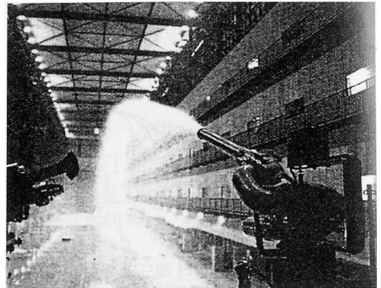
【그림 5】 대규모 화원탐지집중소화시스템
