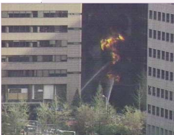
[사진 9] 냉각탑 화재 및 그 진화 광경
