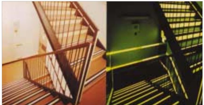
■ 사진 2. 평상시와 암흑 상태에서의 피난유도표지
