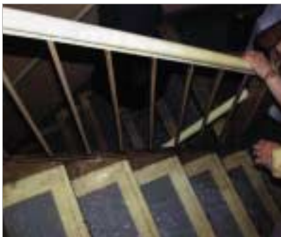
■ 사진 3. 9.11 당시 세계무역센터(World Trade Center) 계단에 설치된 피난유도표지
