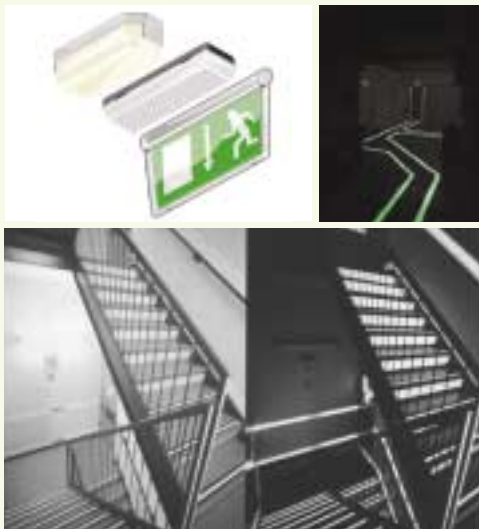
■ 그림 2. 비상조명등, 피난유도등, 피난유도시스템 예
