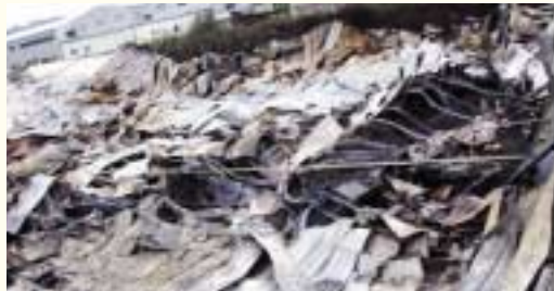
● 사진 5 ● 발화 추정지점 [사진 3] 제품창고 라인 피해 현장
