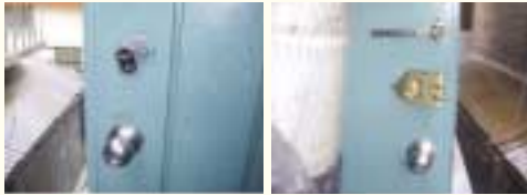
〈사진 4〉 화재발생 주택 출입문 내·외부 사진
