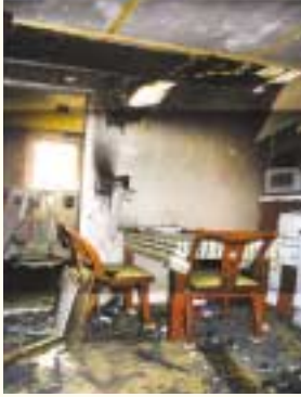
〈사진 2〉 출입문에서 거실 겸 주방을 찍은 사진
