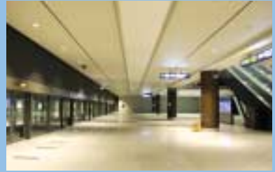
탑승동 A 지하 1층 ITC 승강장
