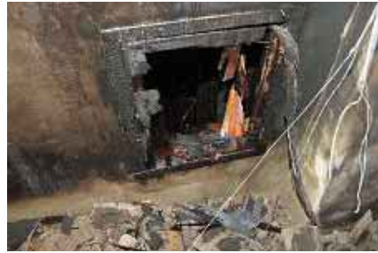
<사진 8> 전력구 비트 덮개를 목재 합판으로 처리하여 쉽게 연소됨.
