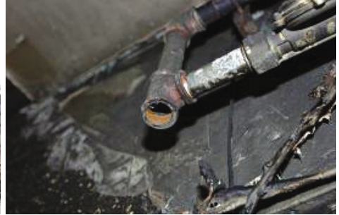
〈사진 7〉 폭발사고 건물(좌), 마감처리가 안된 배관 연결부(우)
