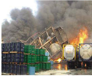
〈사진 1〉 지방산동 붕괴 및 유지료 트레일러 연소
