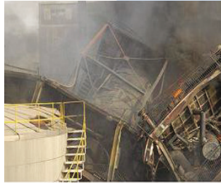
〈사진 2〉 비드타워 붕괴형태 (높이 22m, 직경 2m)
