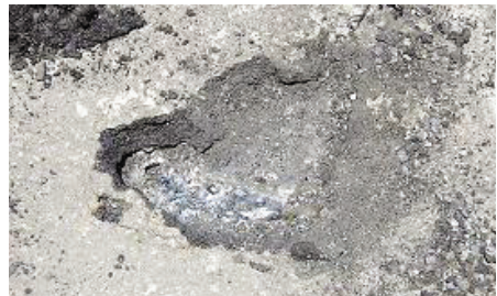
[사진 5] 고압선의 지락발열로 생긴 파열과 유리질 결정물의 생성 형태
