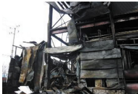
〈사진 3〉 스티로폼 심재가 녹아 패널 철판만 남은 발화장소
