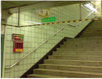
[사진2] 역사 내의 천장 제연 경계벽 설치 모습
