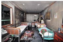
[사진 10] 1층 제①노인생활실 내부의 상황
