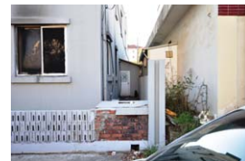
[사진 18] 건물 후면에 출입구 1개소 설치됨
