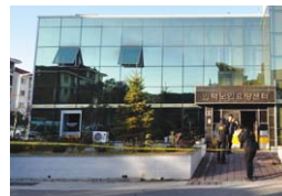
[사진 17] 화재현장의 전면에서 출입구 2개소 설치됨
