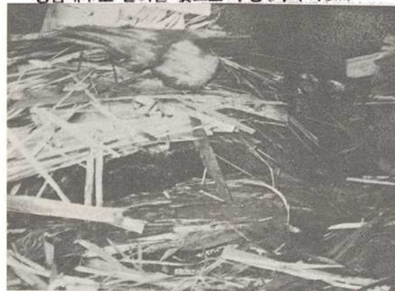
▲ 공장 내부 보일러실에 쌓아 두었던 보일러 화목용 나무 부스러기에 인화 발화됨.
