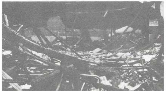
▲ 중앙상부에 보이는 구멍으로 화염이 건너와 공장등에 연소되어 목조건물 전체가 소실됨
