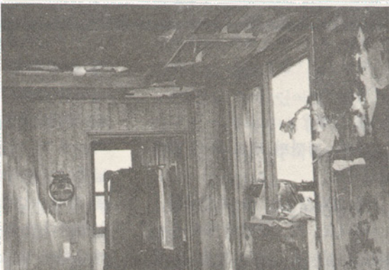
▲ 4모녀가 있던 거실 (3층) : 2층 발화장소로부터 연기와 불꽃이 창문을 통해 들어와 연소되었음.
