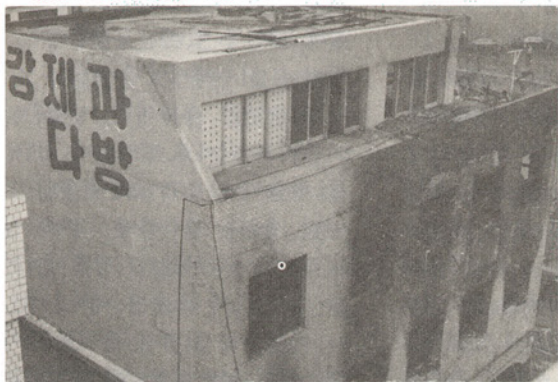
▲ 4모녀가 있던 거실 (3층) : 2층 발화장소로부터 연기와 불꽃이 창문을 통해 들어와 연소되었음.
