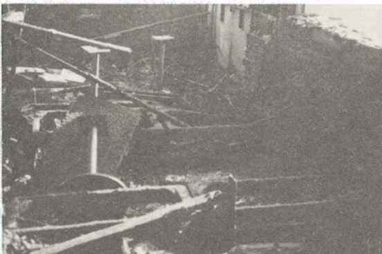
▼ 화재발생장소 (2층) : 타다 남은 내장재와 집기류등.
