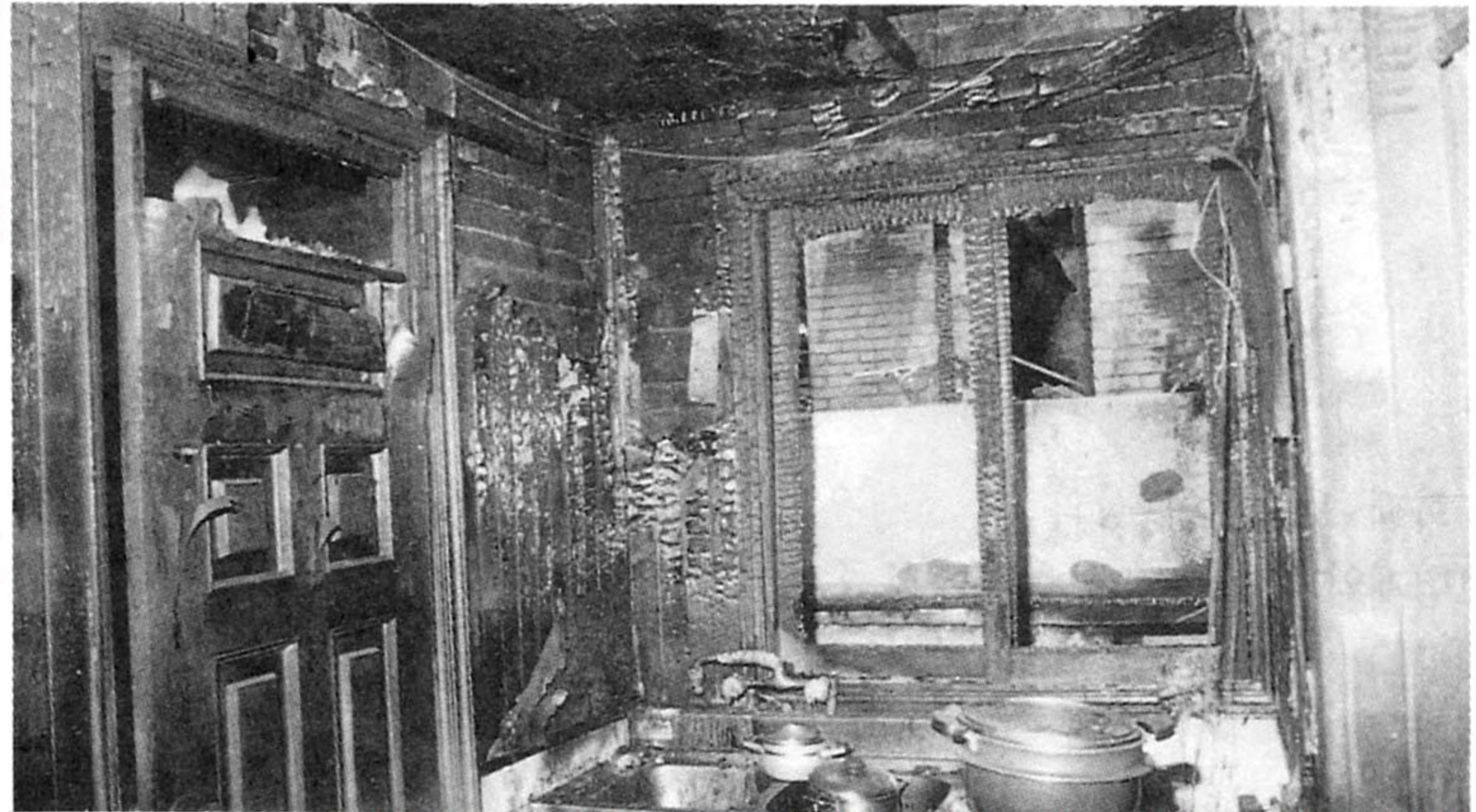
(사진1) 목재류의 탄화심도와 역삼각형적 연소상황은 화염의 진행이 창외측으로부터 내측으로 진행되었음을 알 수 있다.
