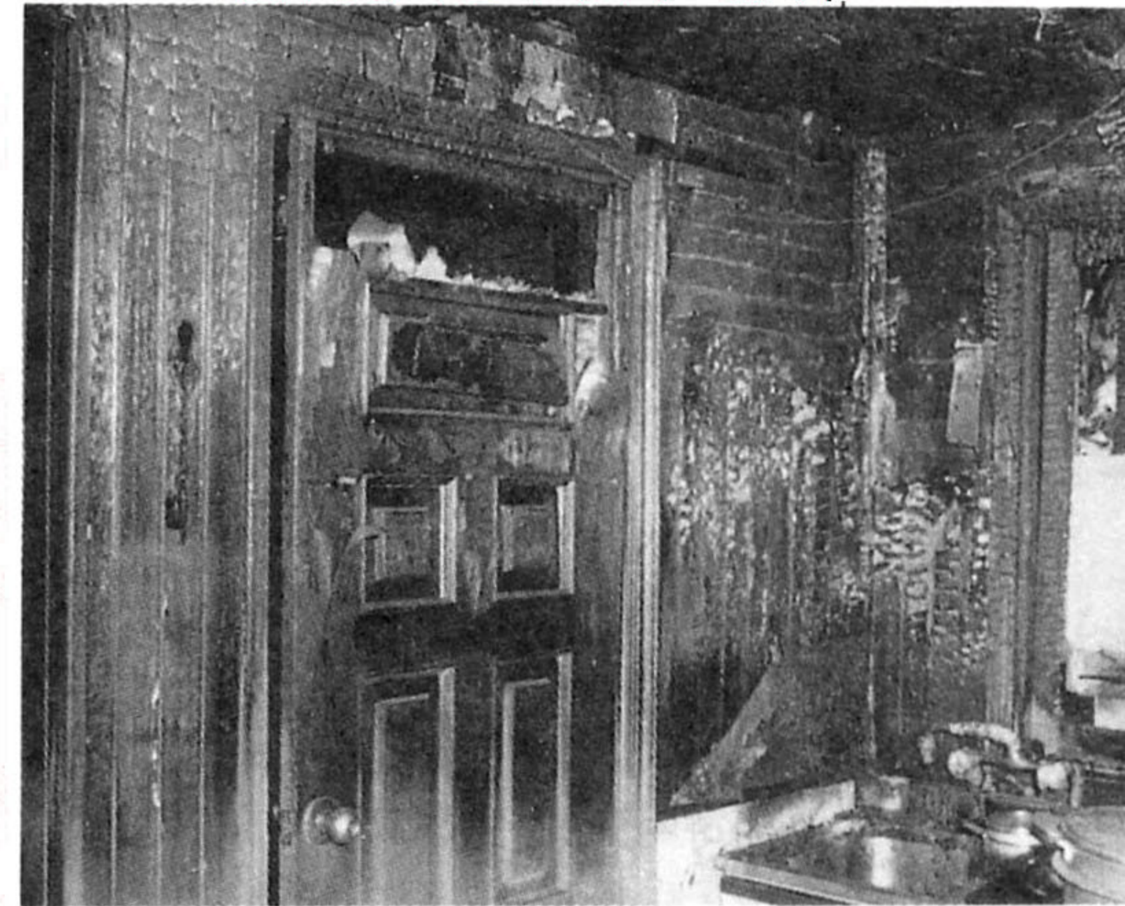
(사진2) 사진1의 출입구 쪽으로서 아래쪽과 위쪽의 연소진행 방향이 쉽게 식별되고 있다.
