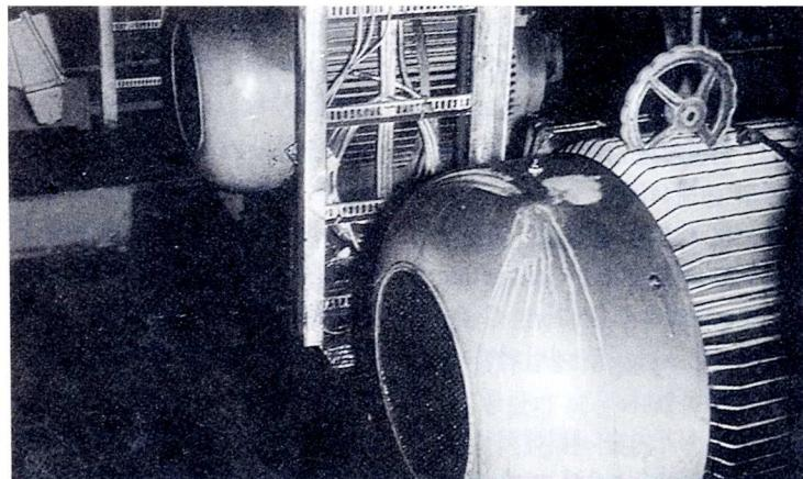
(370kW, 1,500rpm)이 1기 설치되었다. 이 엔진은 공사 기간중은 산상 호텔과 공사중인 역에 전력을 공급하고, 공사 완성 후 전력회사로부터의 송전이 될 때부터는 비상용 발전 장치로 사용하도록 되어 있었다.
