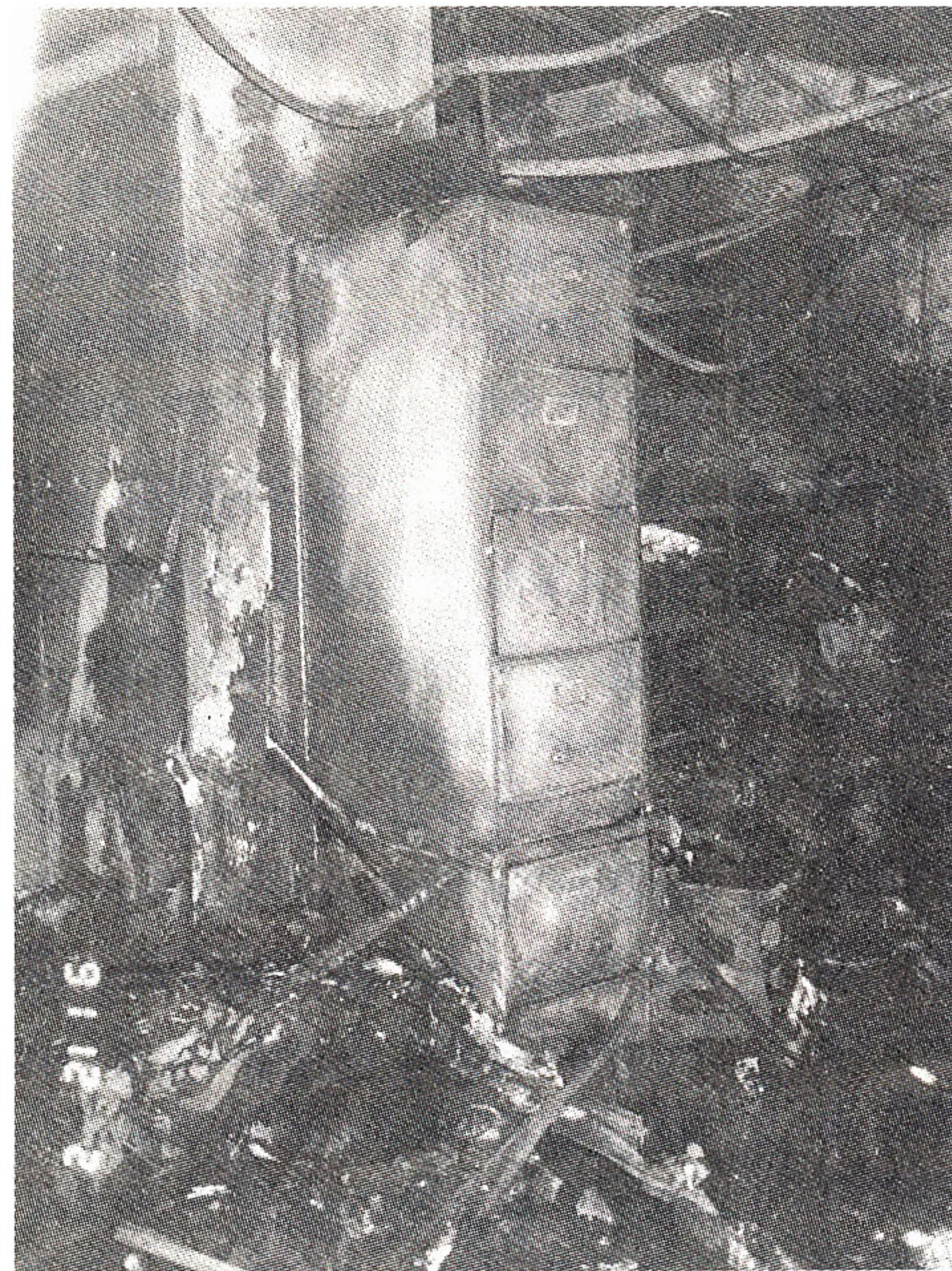
사진 왼쪽, 콘크리트 기둥에 붙여세워진 철제 서류 파일이 사진을 찍은 방향으로 부터 진행되어진 화열을 받아 변색되었음을 볼 수 있다.
